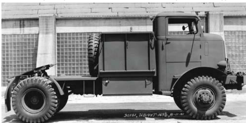
Afb. 03: Amerikaanse staatsiefoto van de Trekker: 6-ton, 4x4, U 8144T [Autocar]. (Foto: Internet)
